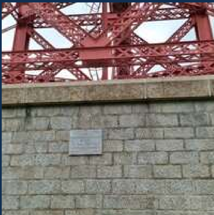
Viaduc de GARABIT pilier sud
